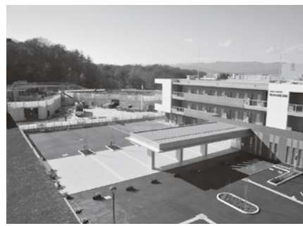
旧松栄小学校用地に整備が進む福祉健康・多世代交流複合施設
