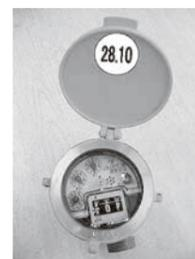
なお、水道メーターの取り替えに合わせて、不具合な止水栓(メーターボックス内のバルブ)の取り替えも行います。▼**該当するメーター(例)** メーターのふたを開け、28.10～29.9までの使用期間のシールがはつてあるメーター。
