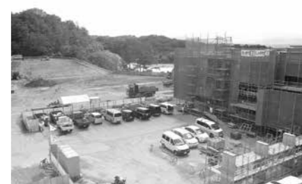
工事が進む「福祉・健康複合エリア」の特別養護老人ホーム(写真右手の建物)と、地域包括ケアセンター建設地(写真左手奥)
