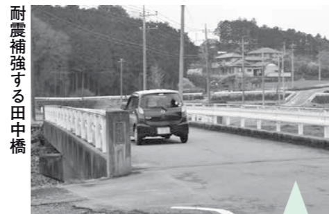
田中橋耐震補強工事 5,500 万円
