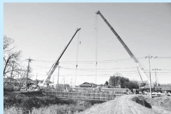
工事が進む亀甲橋（赤沼地内）
