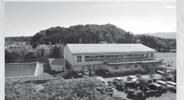
解体する多世代活動交流センター内のプールと体育館
