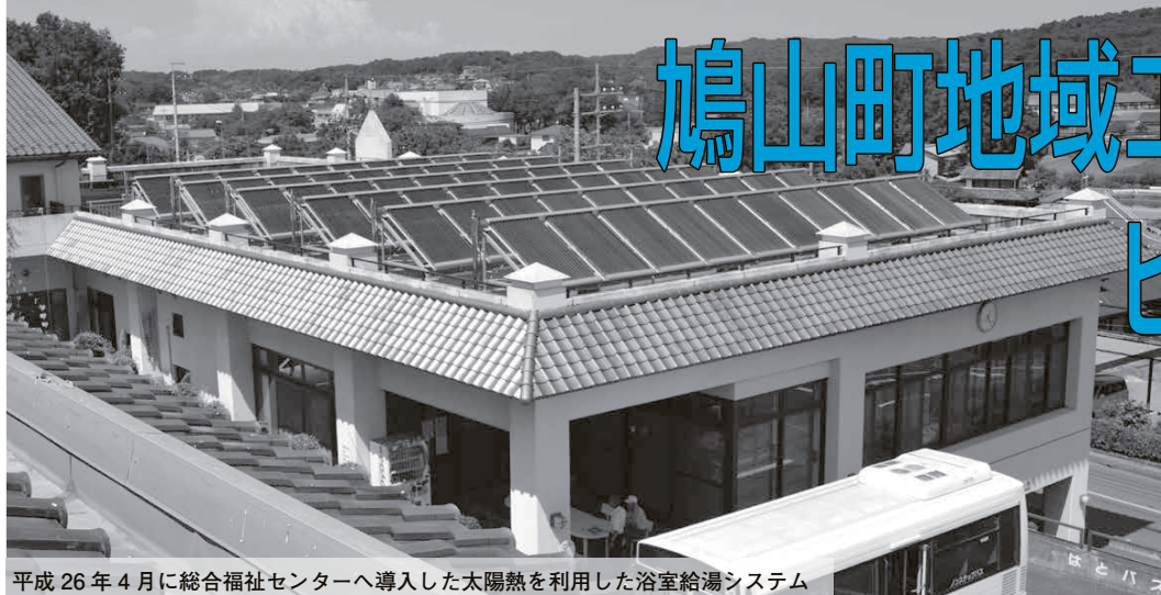
平成 26 年 4 月に総合福祉センターへ導入した太陽熱を利用した浴室給湯システム
