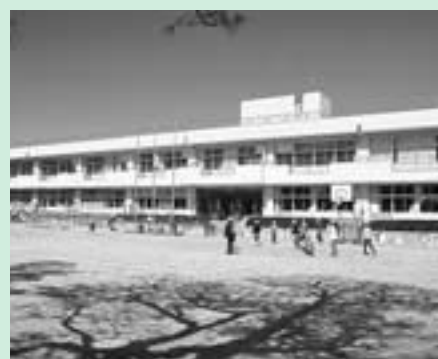
改修工事を実施する亀井小学校
