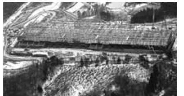
工事が進む建設現場(奥田地内。(株)良品計画提供)
