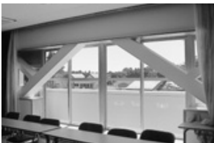
耐震強化の鉄骨ブレース
