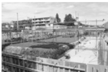
最低制限価格+10万円で落札されたプール改築工事
