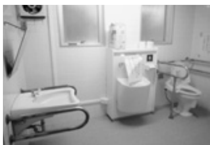
リニューアルした役場庁舎の障がい者用トイレ
