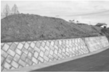
内川沿い擁壁建設現場
