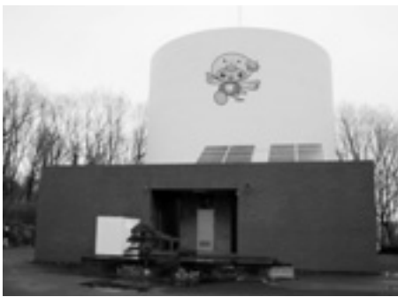
鳩山町配水場
