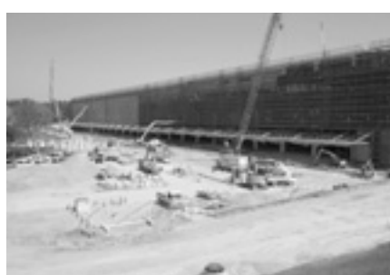
完成間近の良品計画の工事状況
