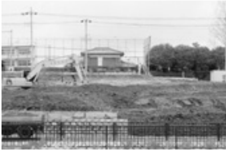
造成工事が進むスーパー建設予定地
