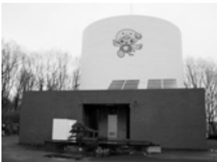
鳩山町配水場
