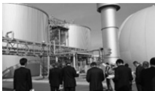
バイオガス装置 寿クリーンセンター(長岡市)
