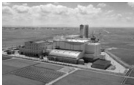
新田清掃センター (新潟市ホームページより)
