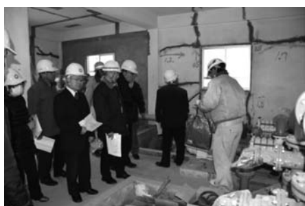
改修工事中の池田浄水場
