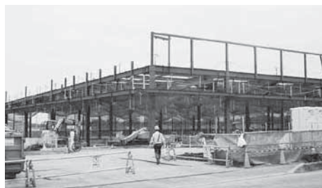
建設工事が進むスーパーマーケット ベイスシア
