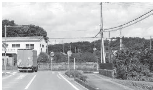
道路改良される町道第1号線(泉井地内)
