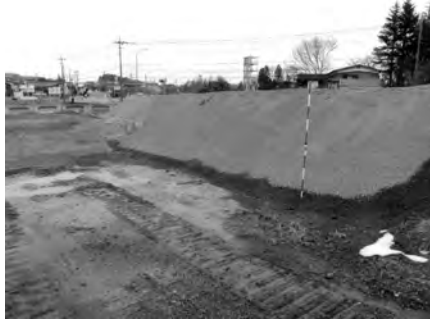
町内の埋立て現場
