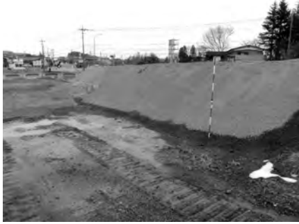
町内の埋立て現場
