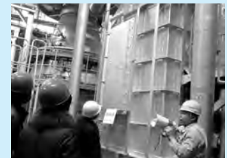
延命化工事がすすむ高倉クリーンセンター
