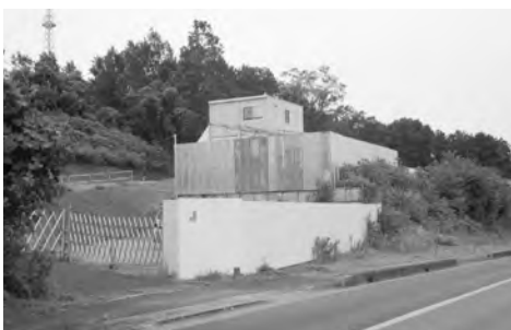
まだまだ指導中の違反建設
