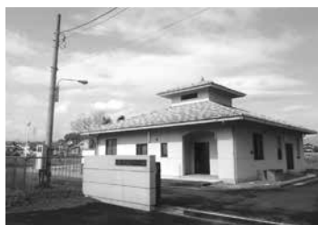
修繕の機器のため排水処理の適切な農業集落排水処理場
