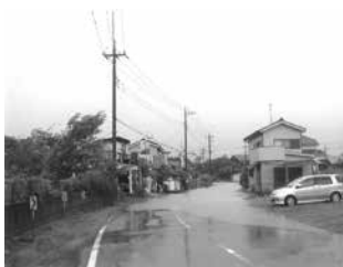
冠水により通行止め規制された重郎橋周辺
