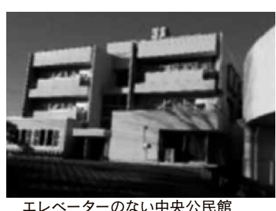
エレベーターのない中央公民館
