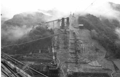
建設中のハツ場ダム本体工事
