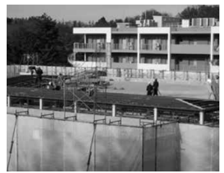
工事が進む地域包括ケアセンター。後方は鳩山松寿園東館
