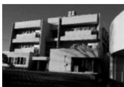
エレベーターのない中央公民館
