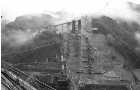
建設中のハツ場ダム本体工事
