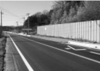
完成した歩道整備工事と進出企業の出入り口付近
