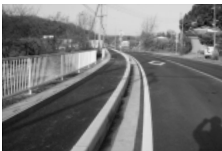
県道東松山越生線歩道整備工事、大橋奥田地内完成
