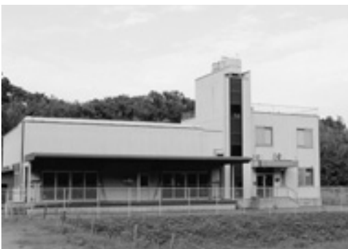
内部の老朽化が心配される給食センター
