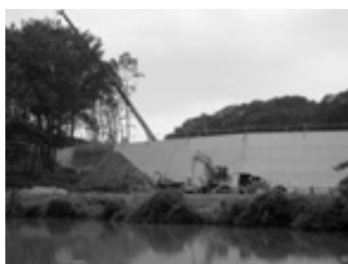
平成26年7月完成めざして急ピッチで進む工事
