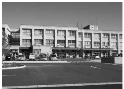
改修工事が見込まれる多世代活動交流センター
