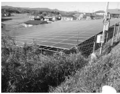
まだまだ続く太陽光発電パネル設置
