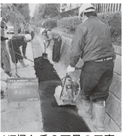
NT楓ヶ丘2丁目の工事
