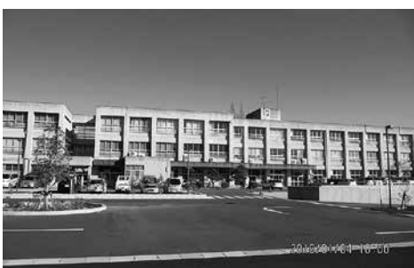
改修工事が始まる多世代活動交流センター
