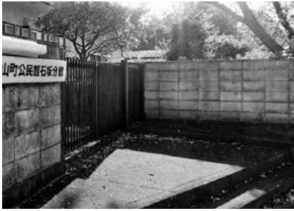
控え壁が設置される ブロック塀
