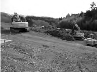
(仮称)鳩山新ごみ焼却施設 工事現場(2月10日現在)
