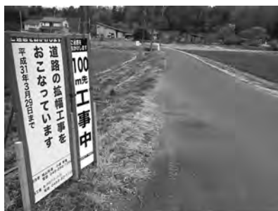
工期、予算も大幅に超過する見込みの町道1号線整備事業
