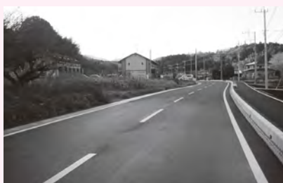
歩道が整備された町道第1号線(第一工区)
