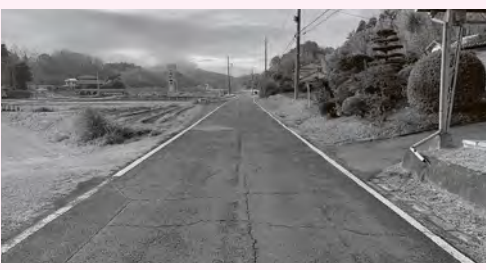
整備予定の町道第52号線
