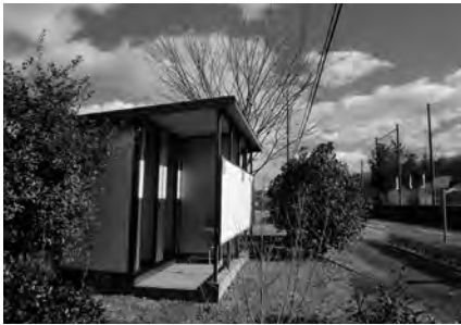
亀井グラウンド駐車場 和式トイレ
