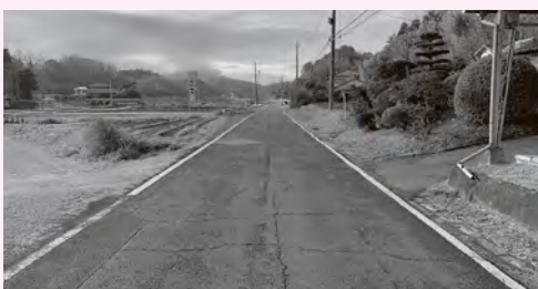
整備予定の町道第52号線
