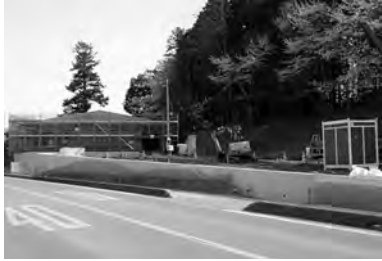
建設が進む泉井集落センター
