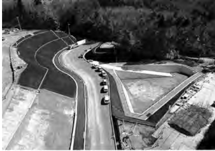
建設が進む(仮称)鳩山新ごみ焼却施設
