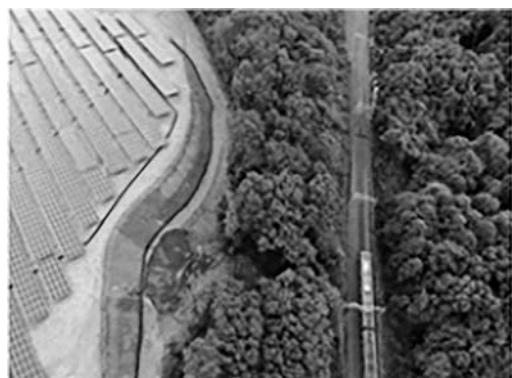
昨年10月に周縁部分が崩落した嵐山町の太陽光発電施設
