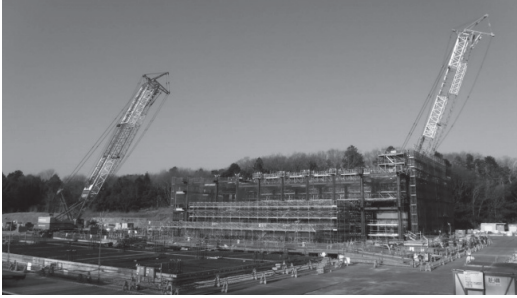
建設が進む新ごみ焼却施設 (組合ホームページより)
