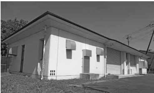
災害復旧工事が施工された鳩山第2中継ポンプ場
