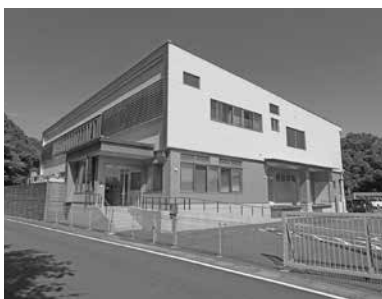
公判で工事価格の漏えいが判明した給食センター
