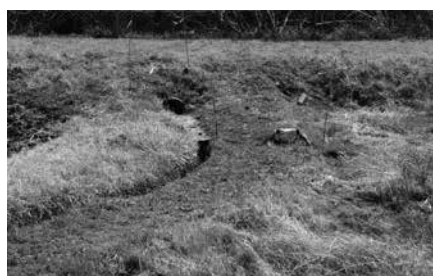
鳩川に流れ込む水路の下流部現状
