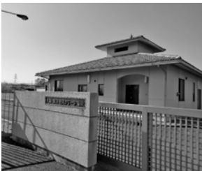
農業集落排水 (大橋・泉井地区クリーン施設)
