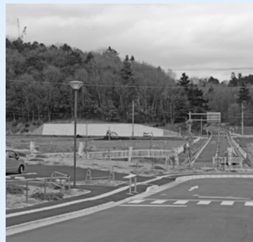
道路標識がないと危険
