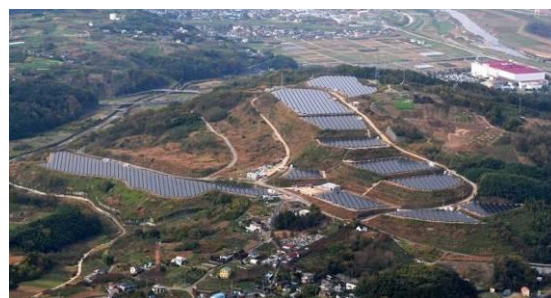
米倉山太陽光発電所（出典：東京電力㈱）
