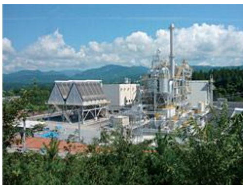
大分県白田ウッドパワー（出力 12,000kW） （出典：経済産業省資源エネルギー庁）
