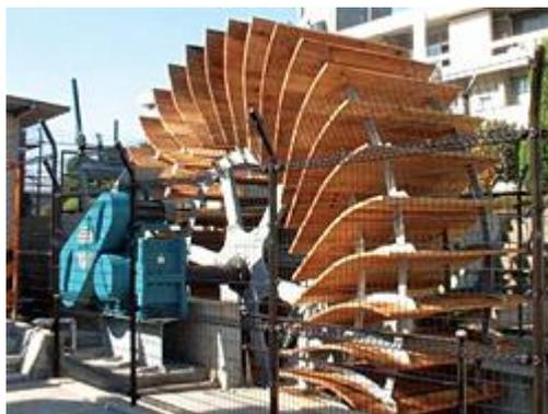
家中川小水力市民発電所（最大出力 20kW）
