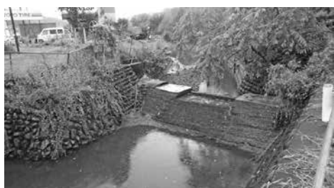
コンクリート堰より転倒堰へ
