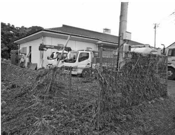
鳩山第2中継ポンプ場
