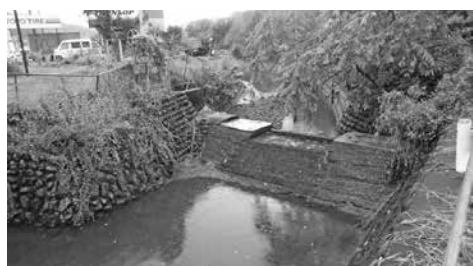
コンクリート堰より転倒堰へ
