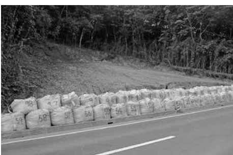
仮復旧工事を終えた 町道第2号線土砂災害現場
