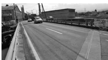
急がれる県道岩殿・岩井線道路改良工事 すぐに冠水する重郎橋
