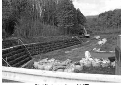
改修中の北ヶ谷沼
