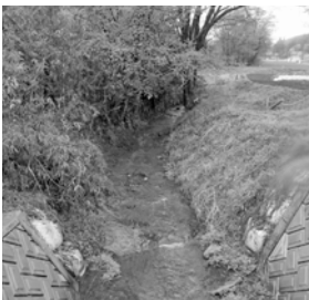
北部地域活性化事業の1つ 辻川改修工事流域
